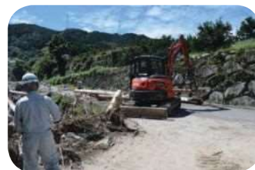
大規模地滑り災害復旧工事現場
