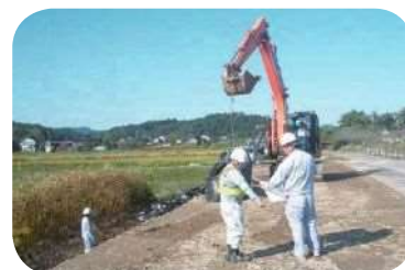
地震災害復旧工事現場
