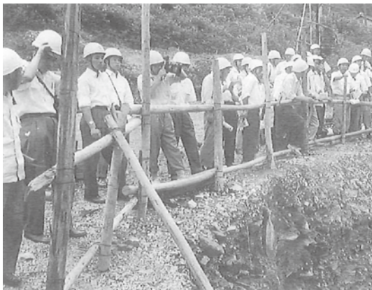
京都大野ダム新設工事現場を 見学する京阪神合同労研メンバー S. 33. 9
